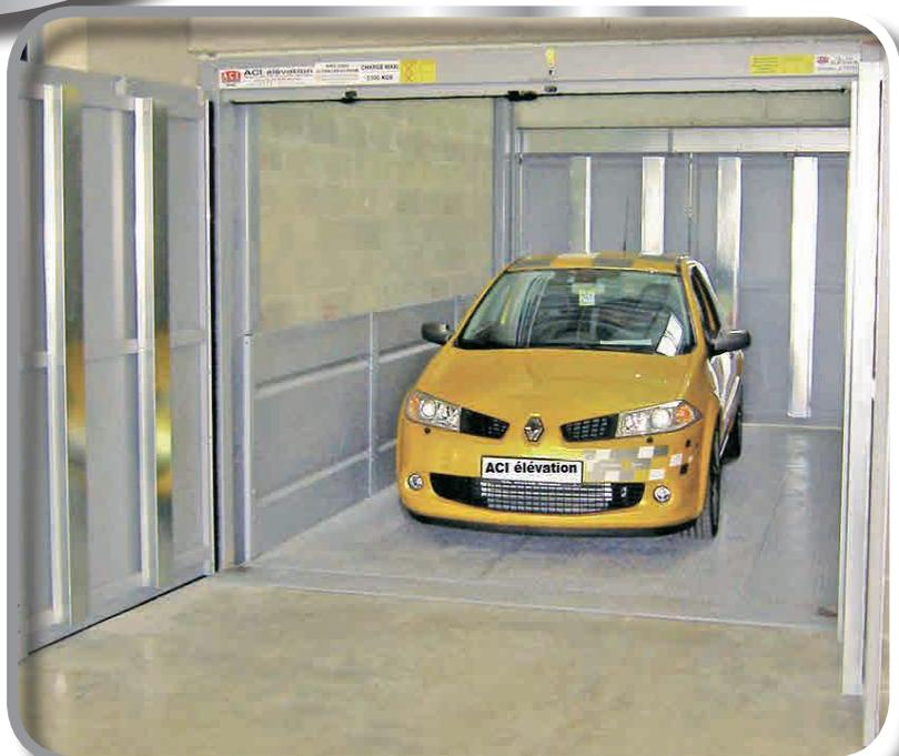
■ Les **monte-voitures** sont conçus pour le transfert de niveau ou le stockage superposé de véhicules entre deux niveaux fixes. Ces appareils sont soumis à des règles moins contraignantes que les ascenseurs de voitures.
